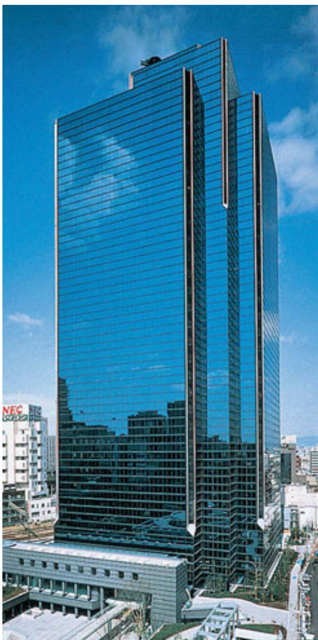
Штаб-квартира DAIKIN INDUSTRIES Ltd, Осака, Япония
