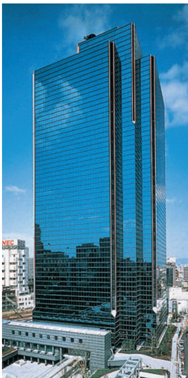
Штаб-квартира DAIKIN INDUSTRIES Ltd, Осака, Япония
