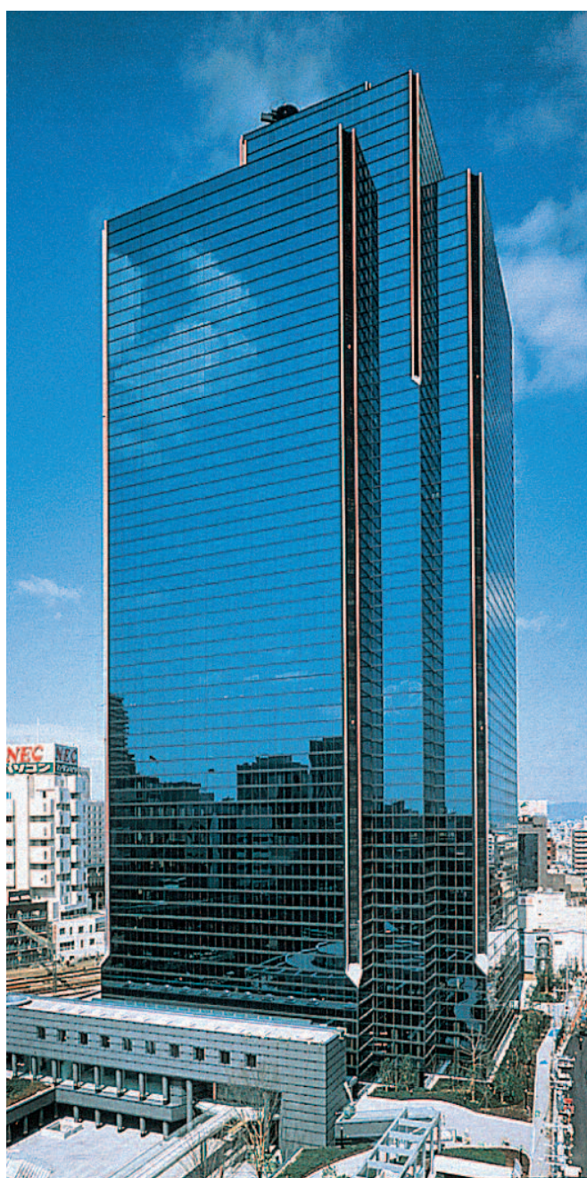
Штаб-квартира DAIKIN INDUSTRIES Ltd, Осака, Япония
